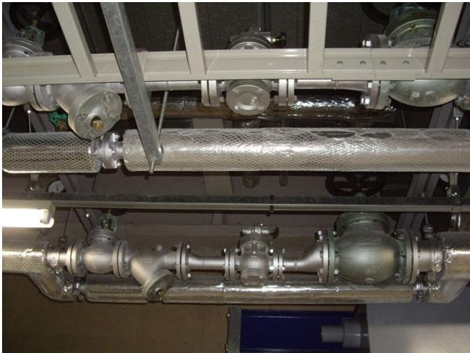
配管は保溫されていても、遮断弁、ストレーナ、減圧弁は未保溫
